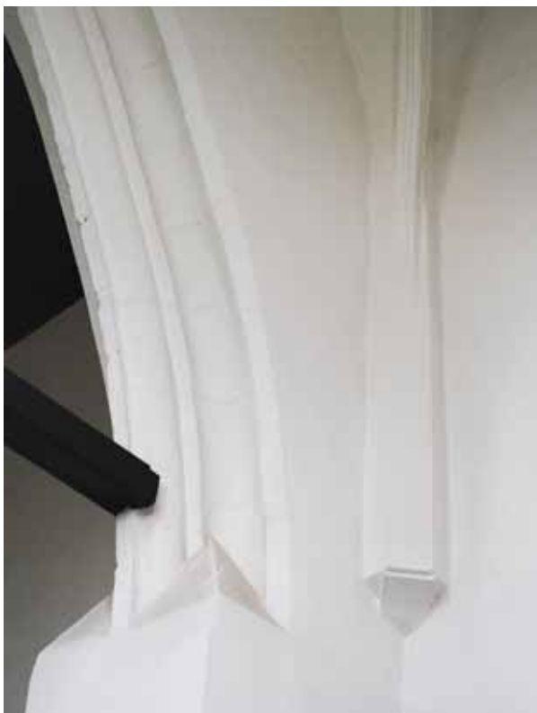
4. Az északi diadalív pillér részlete a szentély északkeleti sarkának boltindításával
