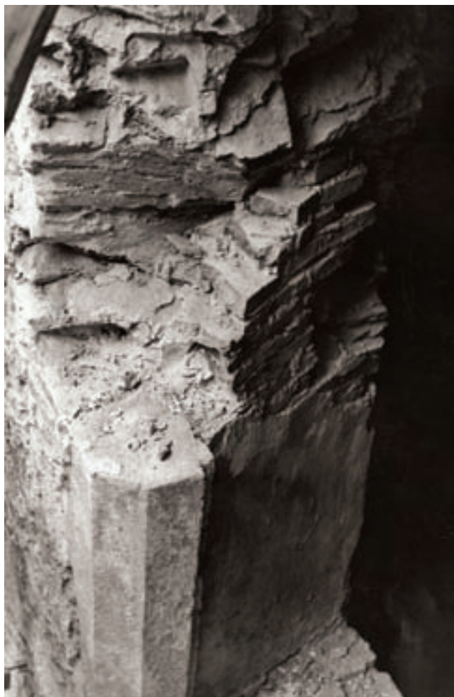
9. A hajó délnyugati ablakának építkezés közben módosított kávája (1978)
