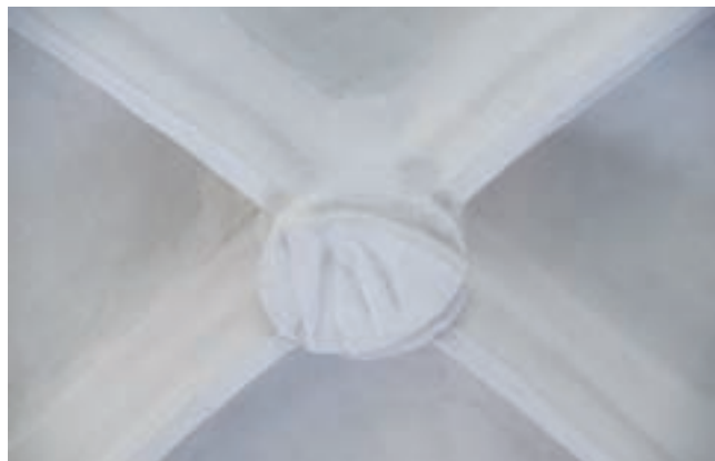
3. A szentély boltozatának Gutkeled-címeres záróköve
