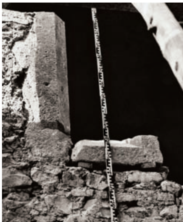
8. A hajó délnyugati ablaknyílása és az eredeti helyére visszahelyezett kőkerete (1978)
