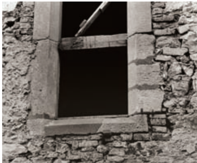
7. A hajó délnyugati ablakának elhibázott rekonstrukciós kísérlete (1978)
